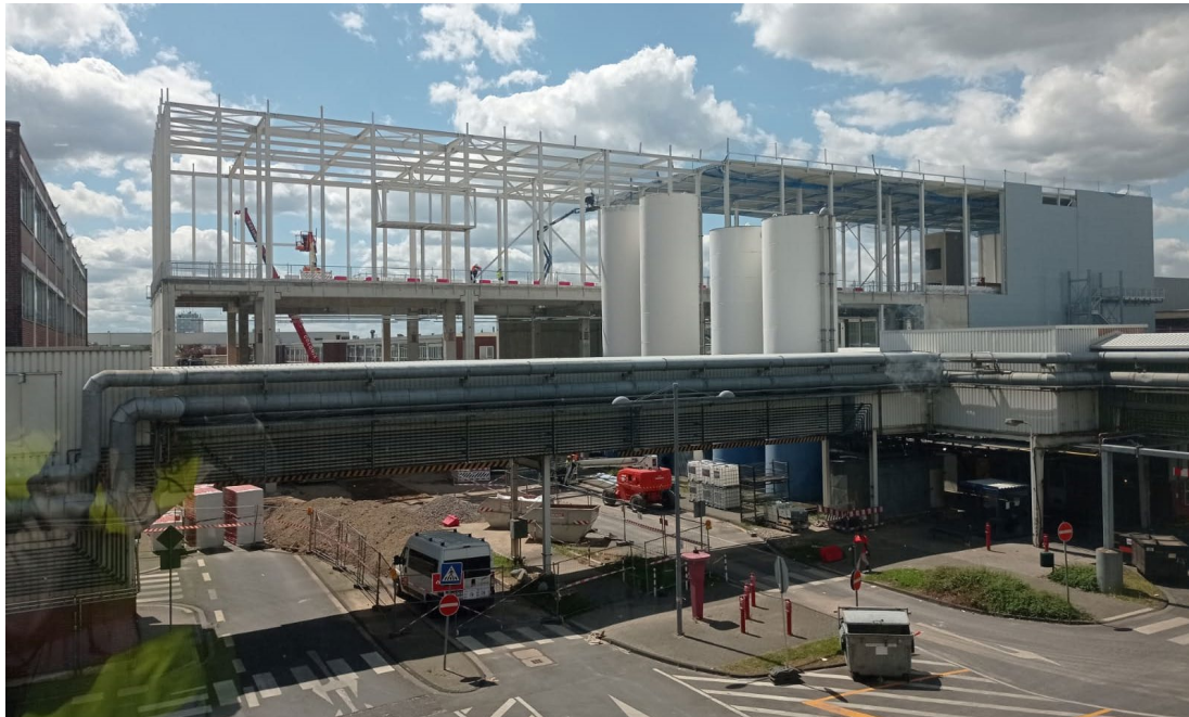
El nuevo edificio durante el proceso de construcción.
